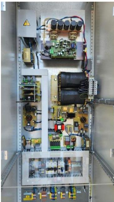
Die maximal verfügbare Wechselrichterleistung beträgt 500kVA (3~) bzw. 200kVA (1~). Für kleinere Leistungen stehen Wechselrichter-Einschubmodule zur Verfügung.
